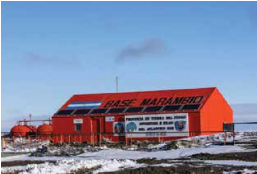
Paneles fotovoltaicos instalados en el techo de un edificio de la base antártica Vicecomodoro Marambio, a 64° de latitud, a escasa distancia al norte del círculo polar.
