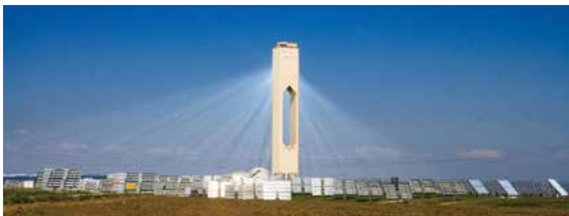
Figura 3. Concentrador de torre central PS10, en Sanlúcar la Mayor, a unos 20km de Sevilla. Tiene una potencia de 11MW y produce unos 23.400MWh anuales de electricidad con 624 grandes espejos móviles llamados heliostatos que concentran la energía en lo alto de la torre de 115m. El costo de construir el dispositivo entre 2004 y 2007 alcanzó los 46 millones de dólares. Foto aflores, Flickr.
