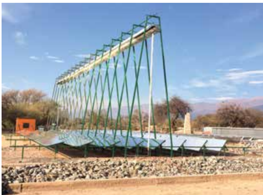
Figura 7. Concentrador lineal Fresnel instalado a título experimental en San Carlos, Salta, por el Instituto de Investigación en Energías No Convencionales y el Instituto Nacional de Tecnología Industrial. El sistema consta de espejos de aluminio de 0,60 x 2,50m montados sobre el suelo de forma tal que su inclinación pueda regularse según el cambio estacional de la altura del Sol. Estos reflejan los rayos solares que les llegan paralelos de manera que se concentren en el dispositivo que absorbe y luego transporta el calor.
