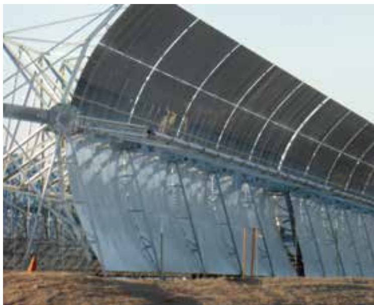
Figura 2. Concentrador parabólico en Harper Lake, localidad del desierto Mojave, en el sur de California. Wikimedia Commons
