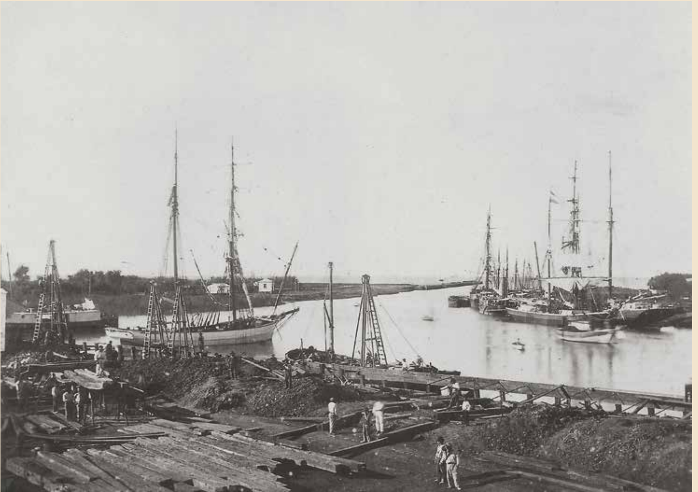
Puerto del Riachuelo. Fotógrafo desconocido, ca. 1879, colección César Gotta. Foto tomada de la margen izquierda mirando hacia la desembocadura. En 1878 se había emprendido el dragado del cauce y la construcción de muelles de amarre como parte de reformas que procuraban dar más capacidad receptiva al pequeño puerto natural usado desde antiguo, el único cercano al centro de la ciudad antes de Puerto Madero.
