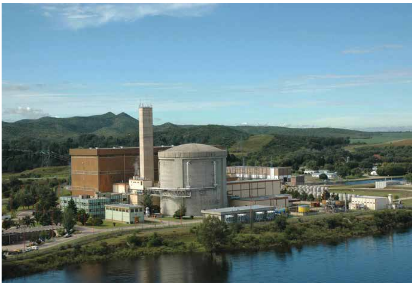
Central Embalse Río Tercero, en funcionamiento desde 1984. La fotografía fue tomada en 2012. Wikimedia Commons
