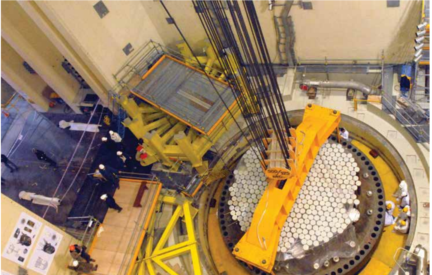
Núcleo del reactor de la central nuclear Atucha 2 en proceso de montaje. Los círculos blancos corresponden a los tapones protegidos de los canales combustibles.
