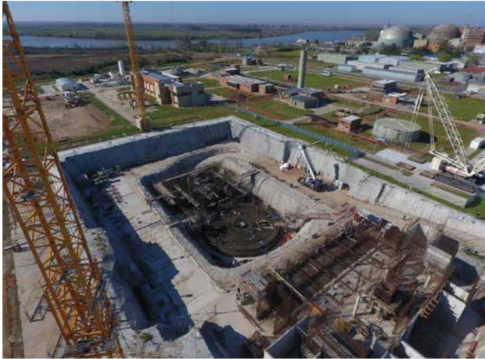
Instalaciones en construcción para el prototipo del reactor Carem emplazado en la costa del Paraná. Arriba a la derecha se aprecian las cúpulas de Atucha I y II. Fotografía tomada en 2016, CNEA.
