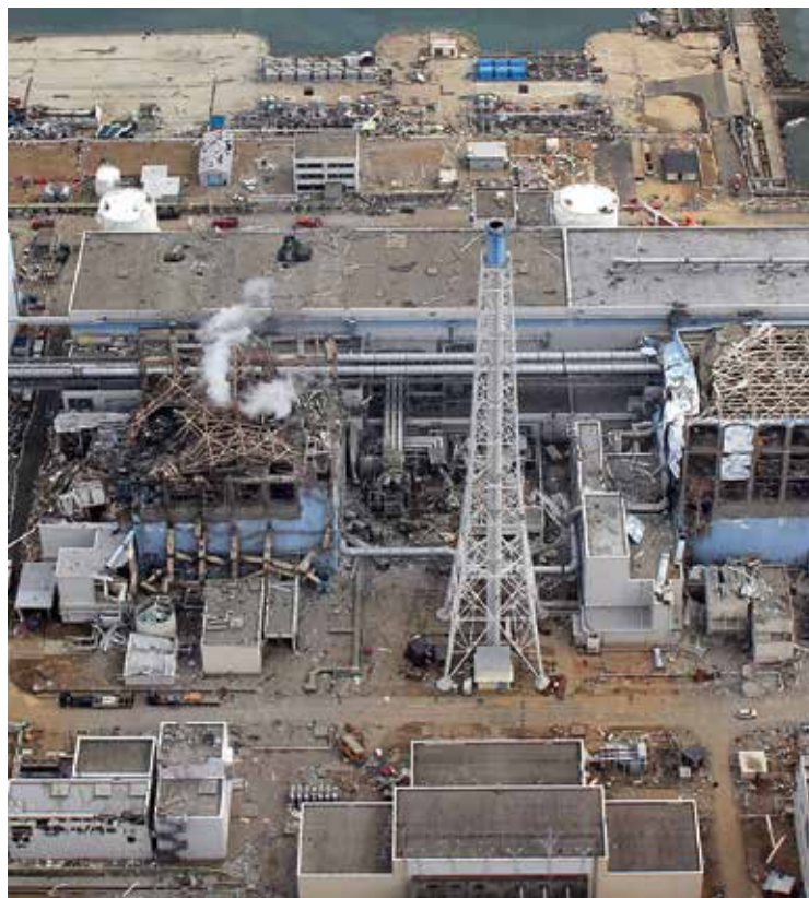
Vista aérea parcial de la central nuclear de Fukushima Dai-ichi después del accidente. Se observan los edificios semidestruídos de dos de los seis reactores que formaban parte de la central.
