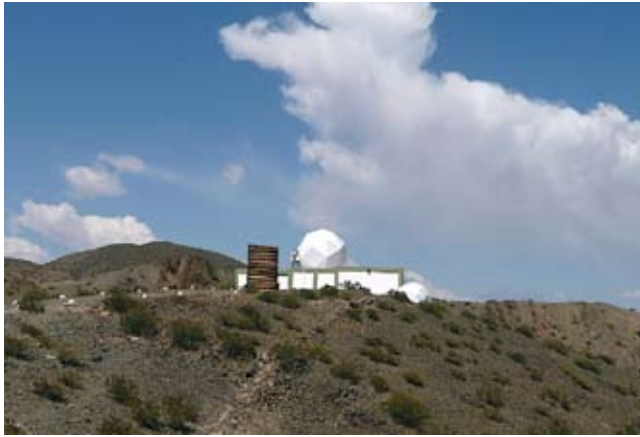
Parte de las instalaciones del complejo astronómico El Leoncito, en las proximidades de Barreal, en la provincia de San Juan.
