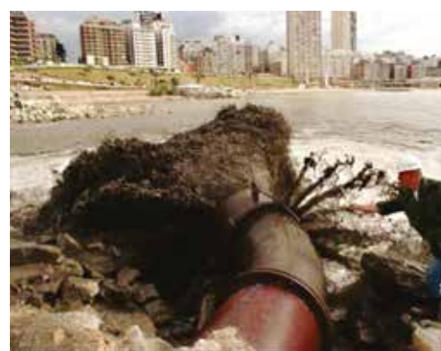
Descarga de la draga que operara en 1998. La playa de 1983, de unos 60m de ancho, fue ampliada a 290m con los trabajos de repoblamiento de 1998. Posteriormente a estos trabajos, la playa fue disminuyendo hasta un ancho de 150m en 2002.
