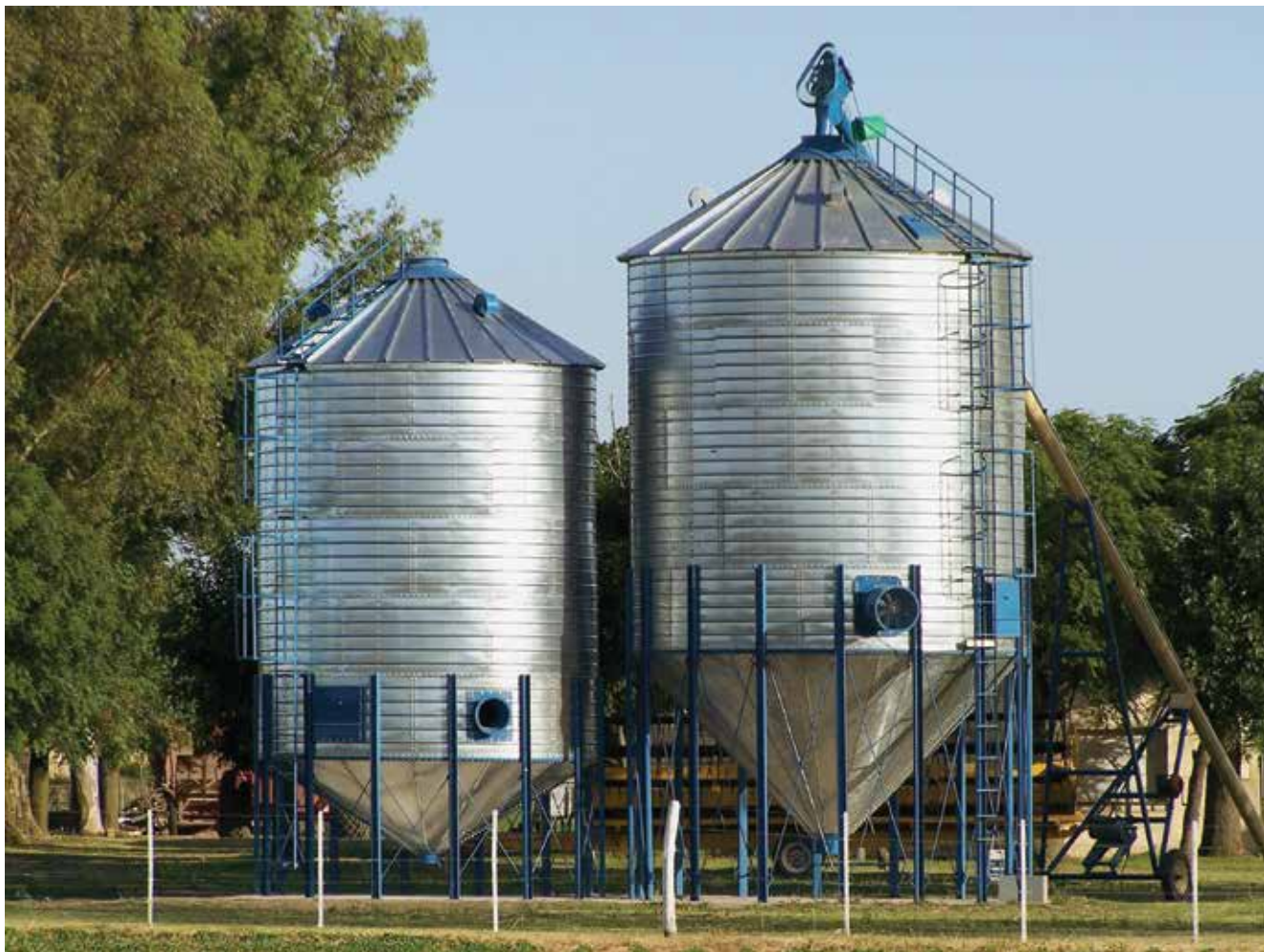
Silos tradicionales de chapa
